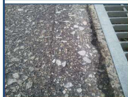
大陽「F-1」で路面の切削
