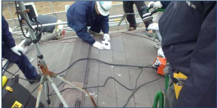
民家屋根 除染作業 アートサンダー使用
