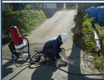
ハンド研磨機でアートカップ(赤)を使用して研磨
